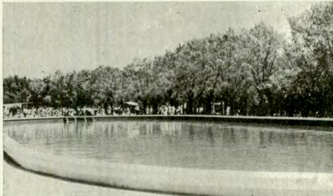
El gran natatorio, construido en un claro de la densa arboleda del Recreo .
